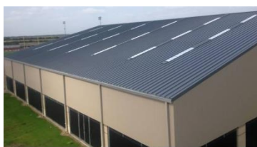
شکل ۴- نمونه‌هایی از کاربرد ساندویچ پنل در سقف سوله‌ها
